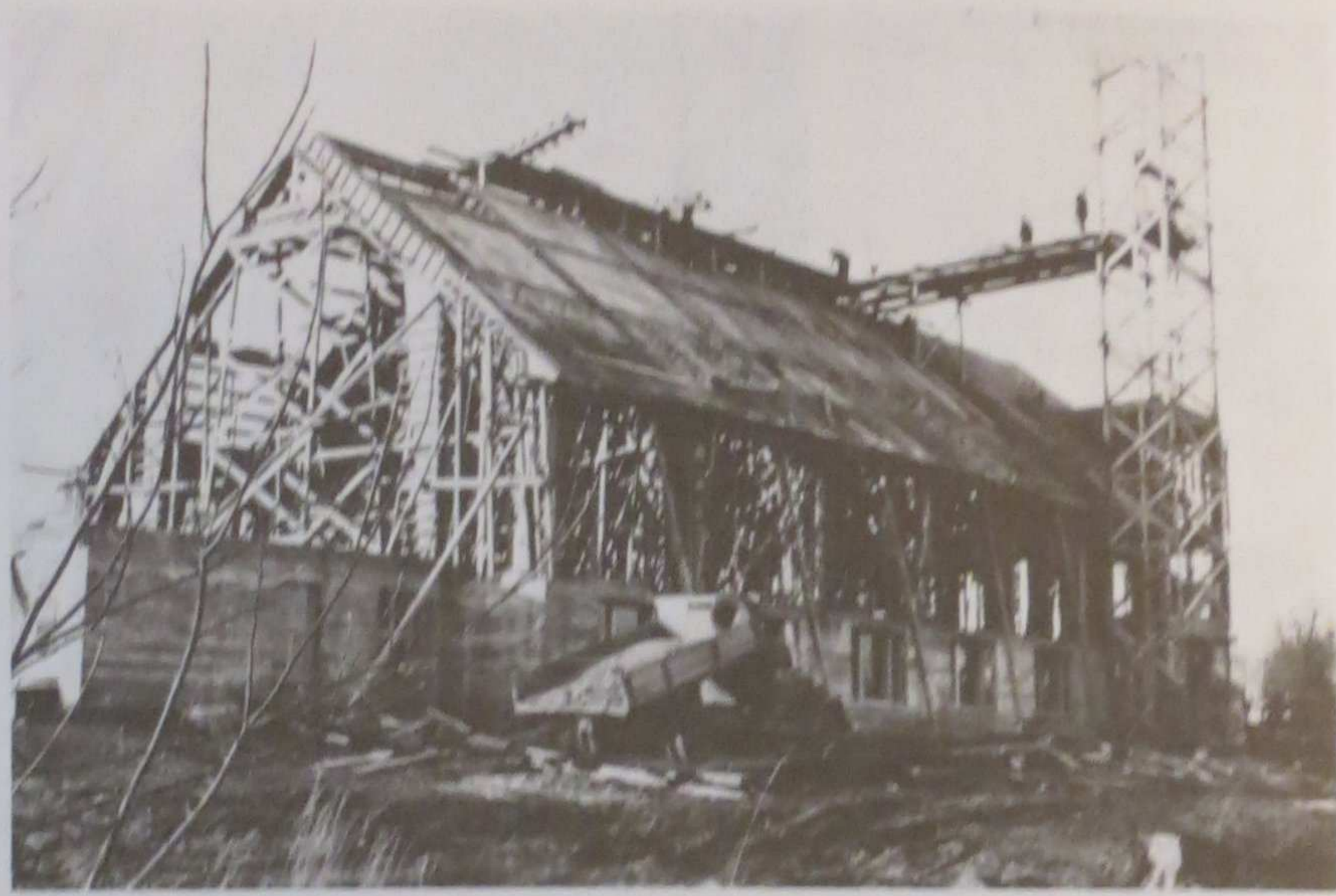
1. On s'affaire à cimenter les panneaux de béton recouvrant le toit.
