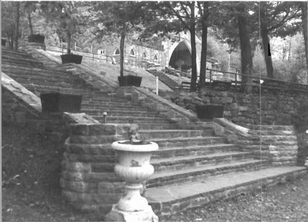
Escaliers de pierre et leurs lampadaires
