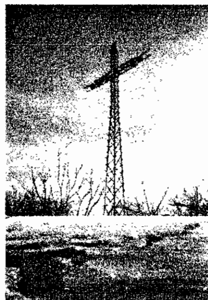
Croix de la Montagne. Remarquez les boules que l'on a ajoutées à cette construction pour équilibrer le tout.
