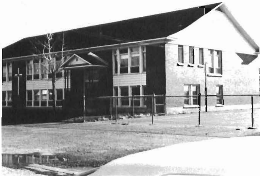
École Piché Dufrost avant l'agrandissement de 1979.
