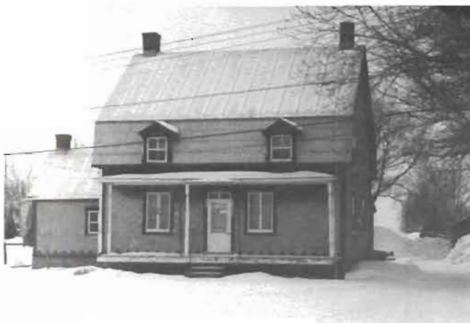
Maison de Hilaire Guérin. Construite en 1875, elle a été épargnée de l'expropriation lors de la construction de la voie maritime. Fut identifiée par la suite comme la maison du barbier (1957-1979).
