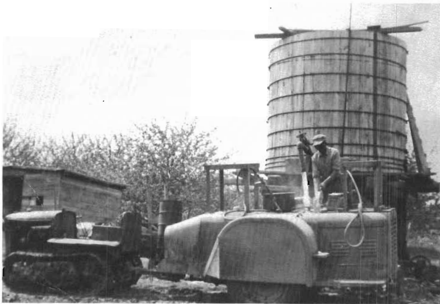
La source du système d'irrigation: une pompe à pistons et un réservoir de 5,000 gallons rempli à raison de 100 gallons/minute. À remarquer les chaînes aux roues du tracteur pour rejoindre les vergers sur les terres boueuses
