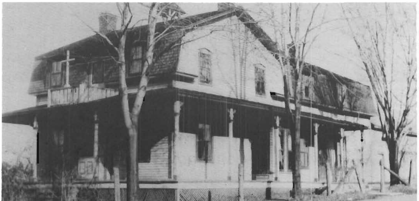
Maison Hamilton, rue de l'Eglise, première résidence des Franciscains à Châteauguay.
