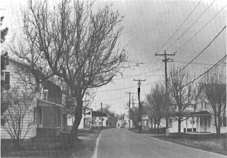
Rue Centrale - Yamaska Est.
