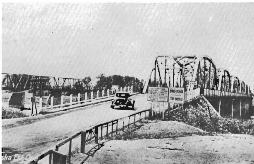
Le Pont à péage - Yamaska Est (1932).
