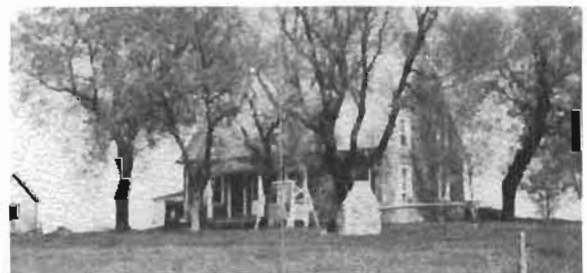
La maison au Petit-Coteau
