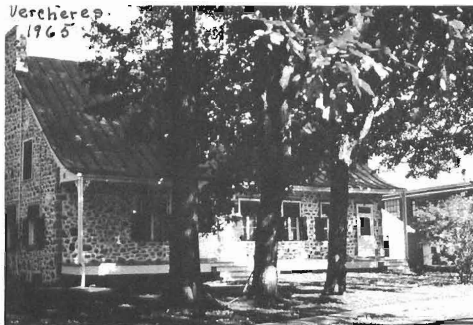
Maison C.A. Bussièrès
