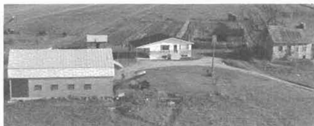
La maison neuve construite en 1975.
