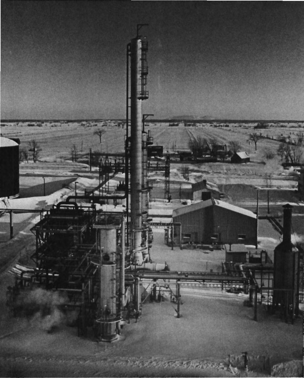
Unité d'hydrotraitement: dernière addition de l'usine pétrochimique Gulf Canada, en septembre 1971.
