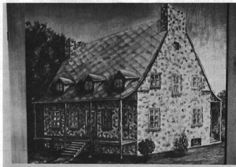
Toiles de A. Albert Dalpé. Les maisons Beauchamp et Beauchemin, rang de la Picardie, construites vers 1770.
