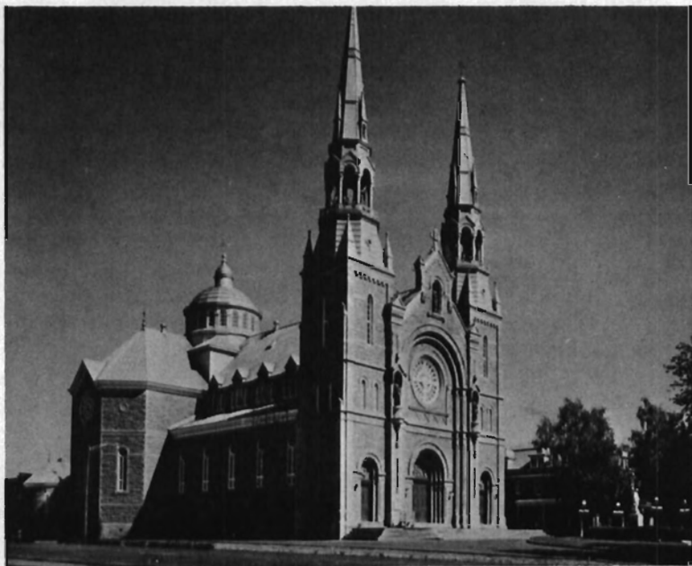
L'église, terminée en 1887. Son architecture est romano-byzantine.
