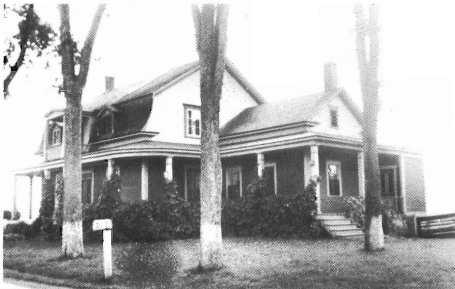
Maison de Monsieur Louis-Victor Vandal, située dans le 3e rang de Saint-Simon. (M. Laval Cusson)
