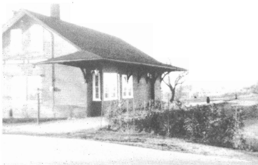
La deuxième gare de Clairvaux datant de 1891 qui servait à l'expédition et à la réception des marchandises et de la poste et dans laquelle on faisait la vente des billets pour les passagers.
