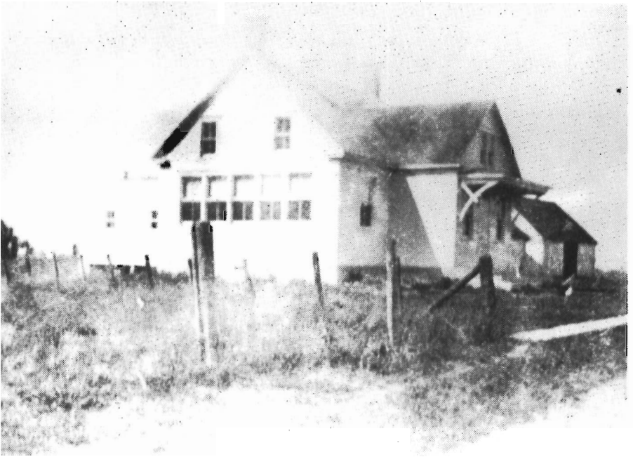
École de l'arrondissement no. 8 (bas du troisième rang) construite en 1897.
