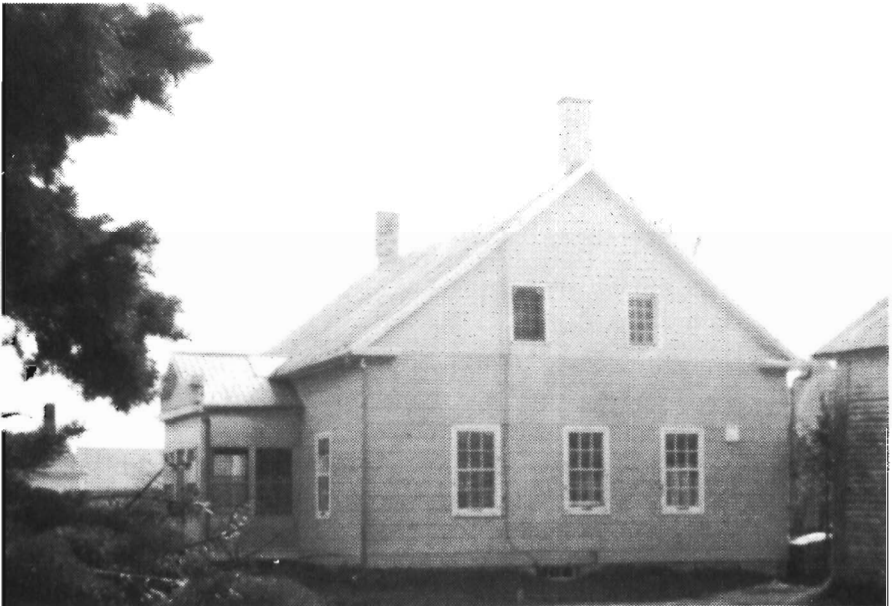
L'une des premières écoles du village fréquentée par les élèves avant la construction du couvent en 1912. Cette maison a appartenu à L. Honoré Marcotte puis fut achetée par M. Anatole Bousquet, marchand général du lieu qui la possède encore aujourd'hui.
