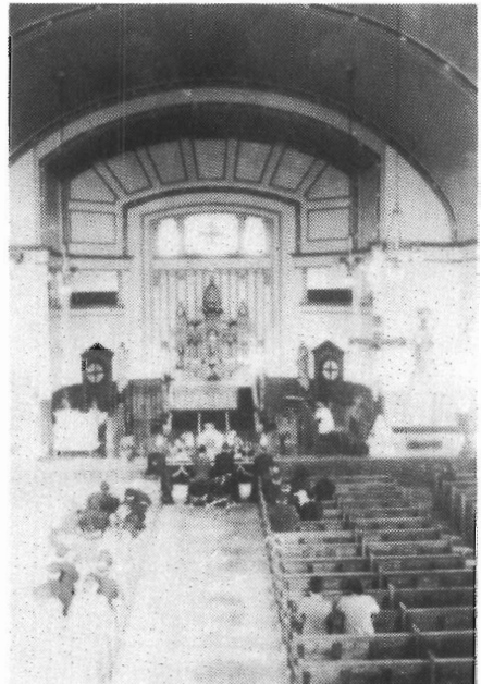
Intérieur de l'église avant les rénovations de 1955 entreprises par la Fabrique sous l'instigation du curé Ravenelle.
