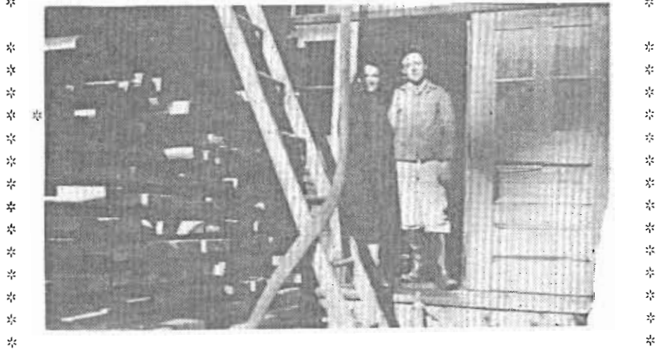
M. et Mme Gaston Ménéard constatant les dommages.
