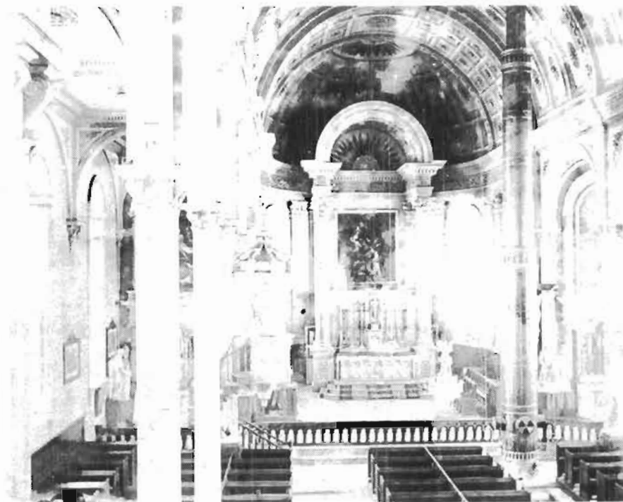
Systeme de chauffage amélioré, les tuyaux sont enlevés, moins dangereux pour incendie. La décoration intérieure est une oeuvre d'art.
