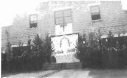
Deuxième étage qui servira de salle pour diverses réceptions. En avant, on aperçoit un reposoir préparé pour la Fête Dieu. Ce garage fut édifié au moyen de blocs de ciment fabriqués à la main un par un sur l'emplacement même du futur établissement.
