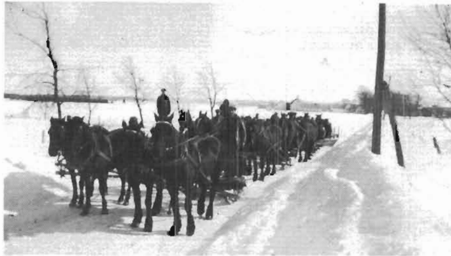
Ouverture des chemins dans le rang du Brûlé en 1932, avec une charrue à neige fabriquée par un groupe de « patenteurs » du rang. 16 chevaux sont attelés pour trainer cette charrue, les cultivateurs y allaient à tour de rôle se remplaçant deux ou trois fois après une tempête.
