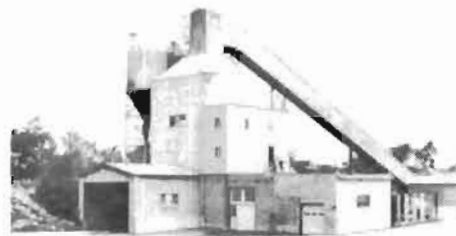
Aujourd'hui : Nouvelle usine de béton d'une capacité de 1 000 verges cubés par jour.
