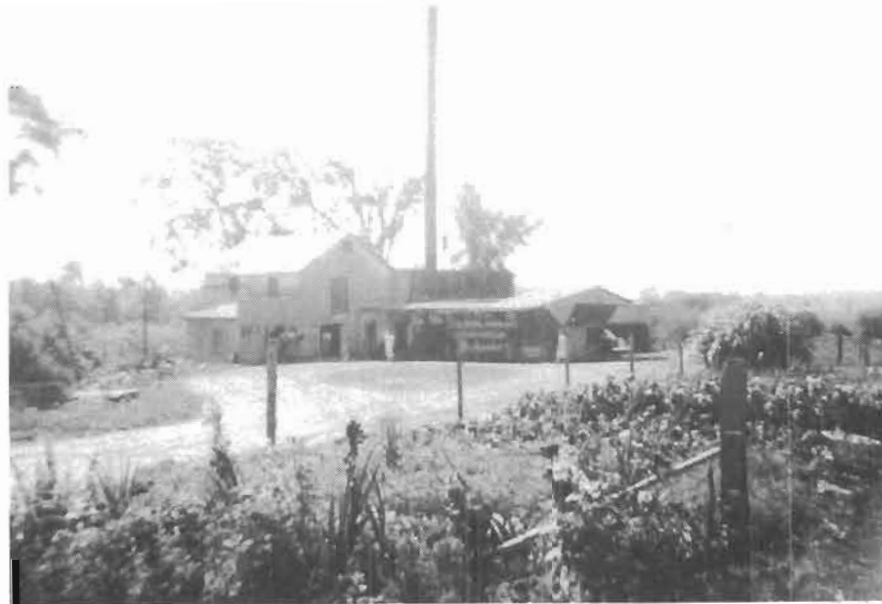
Vue d'ensemble du moulin en 1954.
