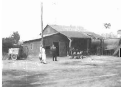
La cabane du « boiler » rattachée au plan d'asphalte en 1944.
