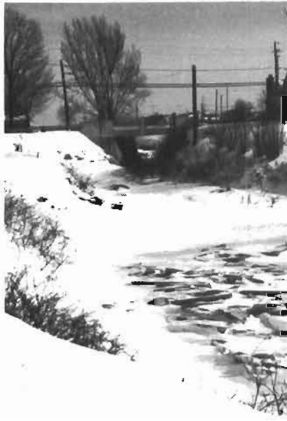
Prise de vue du ruisseau « la Senelle » à l'entrée nord du village.
