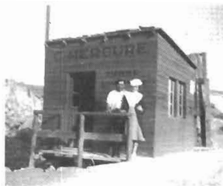
Première balance sur le site des Carrières en 1943. Lucien Lafond compte trente-sept ans de service, à son actif; il est aujourd'hui décédé.
