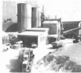
Aujourd'hui : Nouvelle usine de pierre à chaux "cacho" d'une capacité de 2 000 tonnes par jour.
