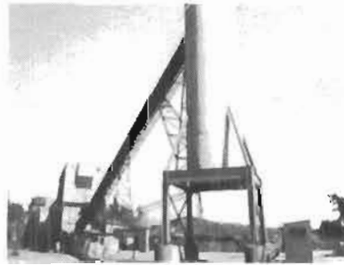
Aujourd'hui : Nouveau silo servant à emmagasiner la pierre criblée provenant de l'usine de concassage no. 2.
