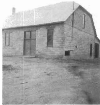
Nouvelle construction de la beurrerie à la suite de l'incendie.
