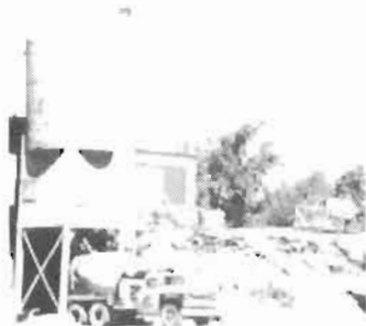
Hier : Ancienne usine de béton, capacité de 200 verges cubés par jour.
