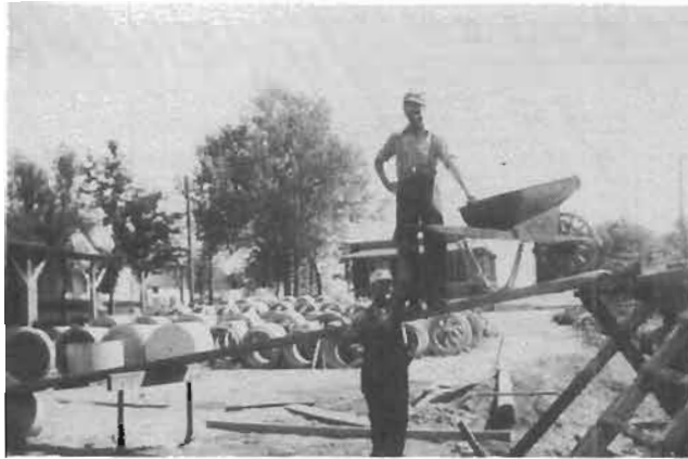
Manufacture de béton.
