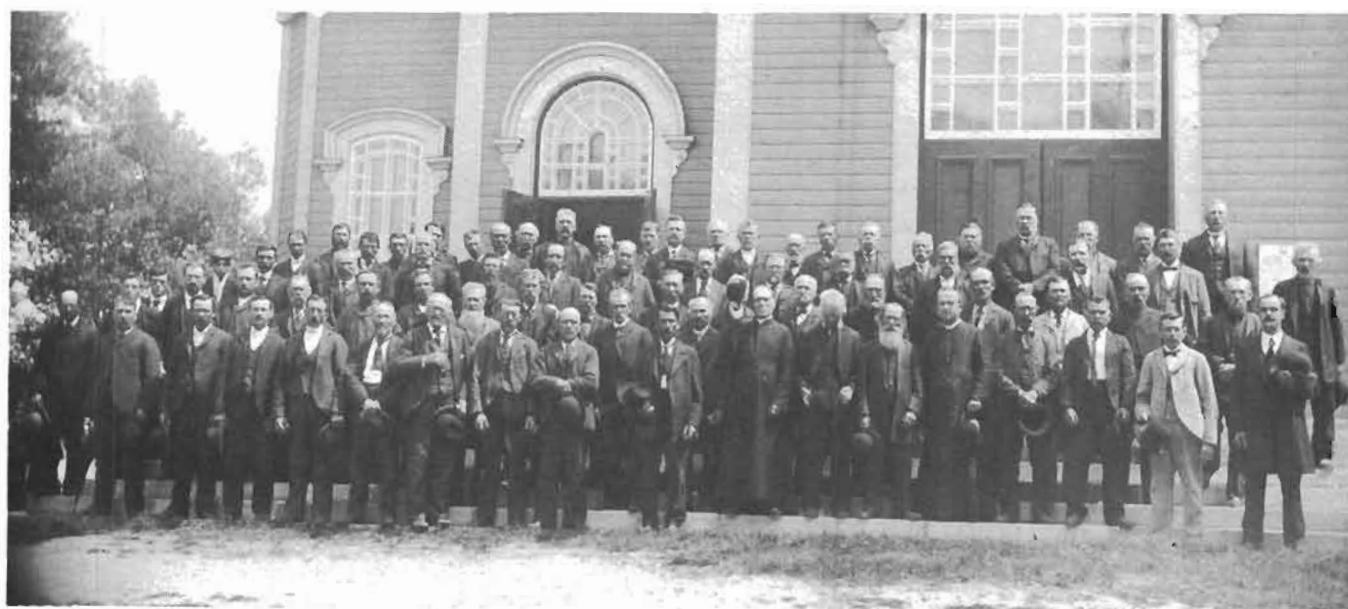
Les bénévoles qui ont participé à la rénovation de l'église.
