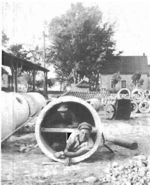
Manufacture de béton.
