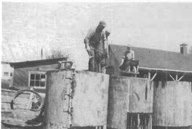
Manufacture de béton.
