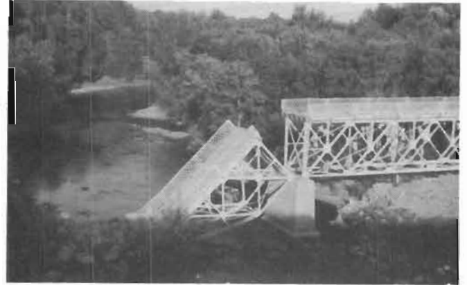
Démolition du Pont noir en 1979.
