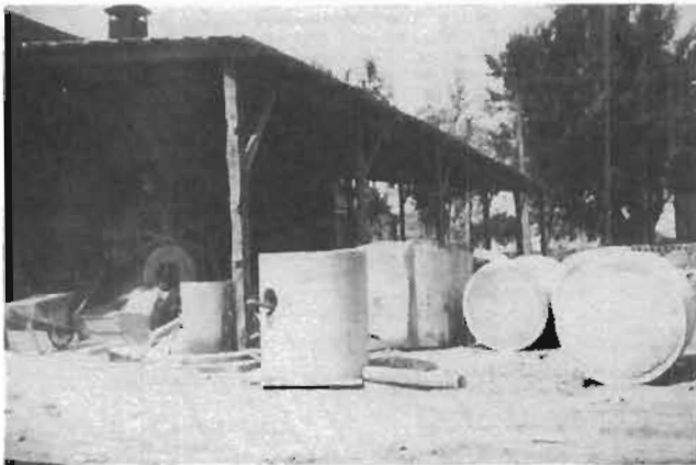
Manufacture de béton.
