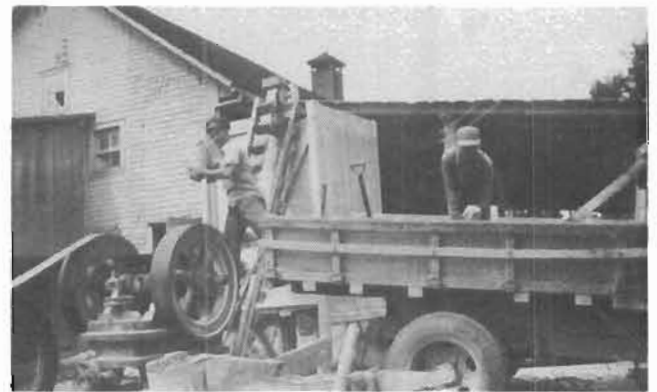
Manufacture de béton.
