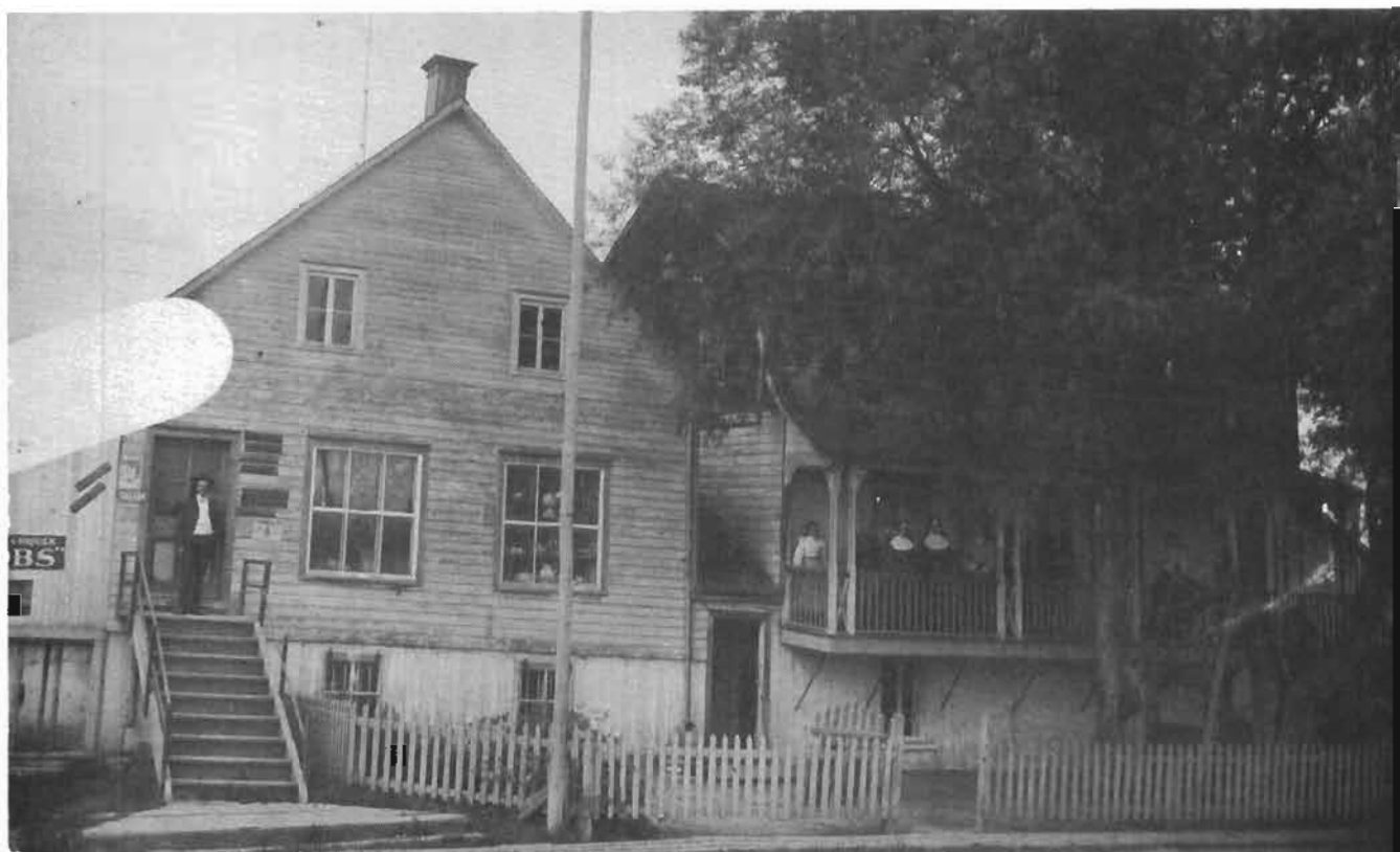
Devant la porte du premier magasin général de St-Édouard M. Apollinaire Coulombe, successeur de M. Ferdinand (fondateur, 1870) La résidence privée toujours existante, le magasin démoli en 1969.
