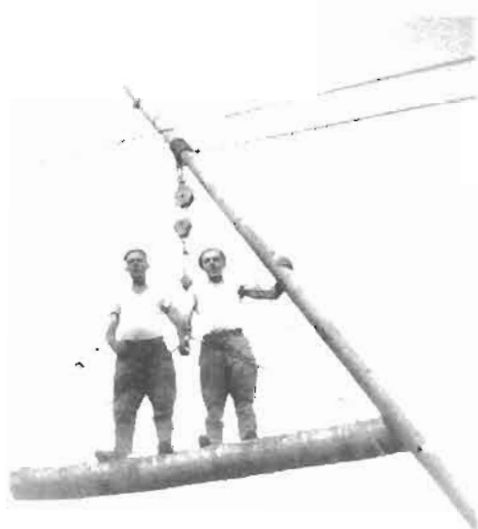
Installation pour monter les billots au moulin à scie.
