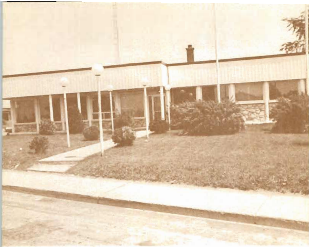
Nouveau Poste de Police situé au 696, Notre-Dame.
