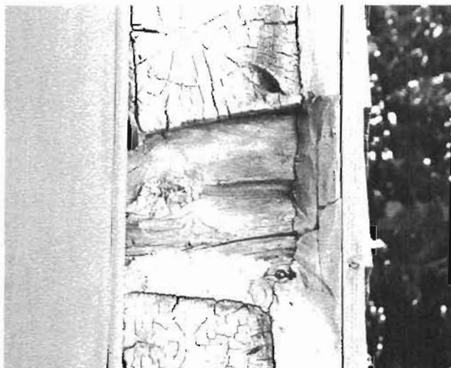
Joints à queue d'aronde noyés de mortier
