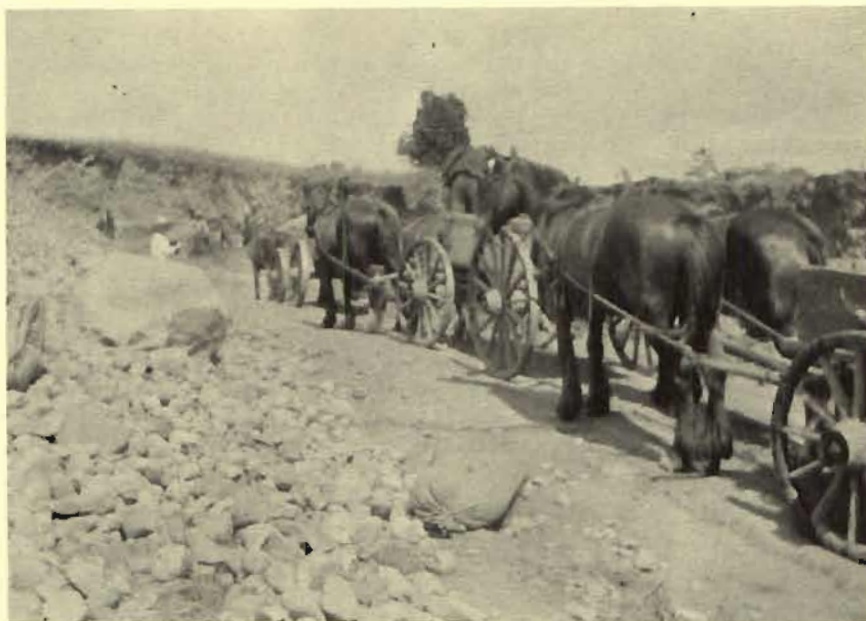
Construction du chemin du Lac.
