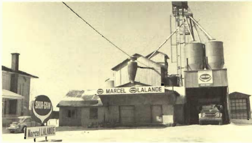
Meunerie ayant appartenue à M. Arcade Benoit.
