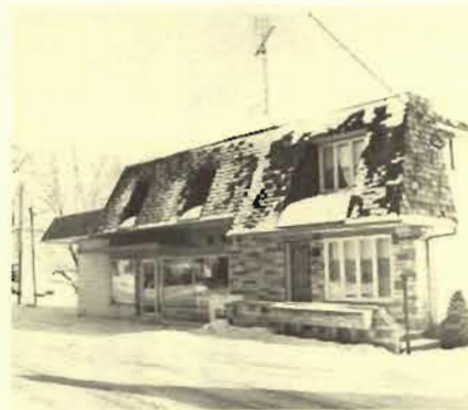
Epicerie rénovée en 1969 et 1977.
