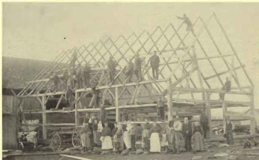
Construction de la grange chez Julien Girouard en 1909.
