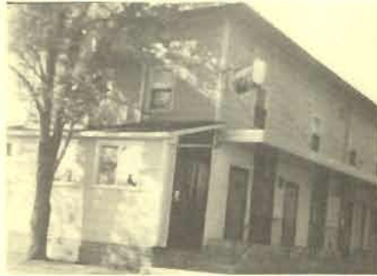
Hôtel La Villa après rénovation en 1962.
