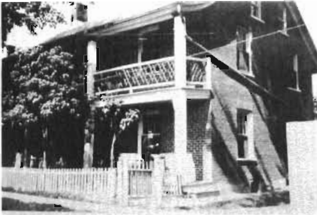
Ancien presbytère (rue Bridge)
