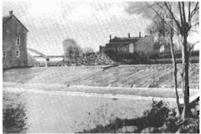
Le barrage à Ormstown - The dam
