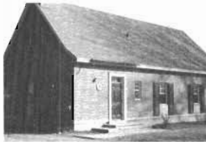
Installations de Bell Canada, rue Prince-Albert
