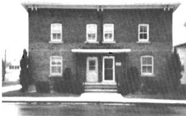
Étude des notaires, située à 11, rue Bridge, Ormstown
