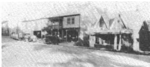
Garage Pierre Guérin, rue Bridge
