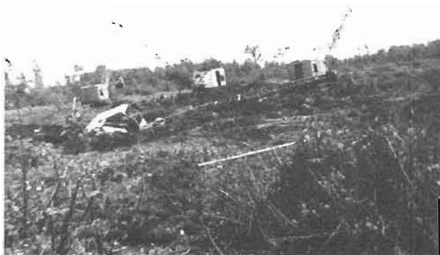
On aperçoit la pelle mécanique de M. Eugène Brosseau. Il a fallu 3 autres pelles pour la dégager
