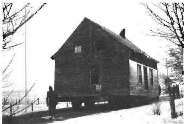
Le transport d'une maison
