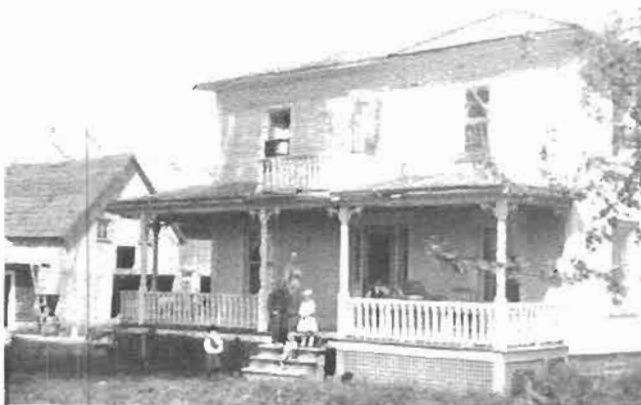
Maison de la ferme
