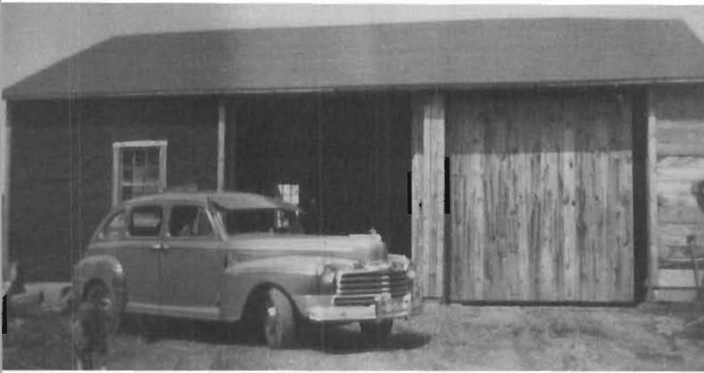
C'est dans ce bâtiment haussé de quelques pieds qu'Arthur et Conrad Gamache débutèrent, en 1971, les opérations du futur Centre du camion Gamache.
