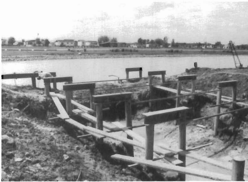
Travaux de construction de la marina Gagnon.
