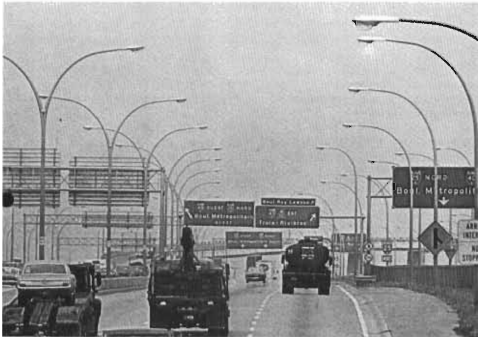
Portiques d'enseignes et lampadaires Pole-Lite sur la route Trans-canadienne.
