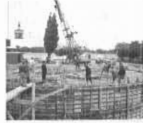
Station de pompage Ville de St-Jean (1966)
