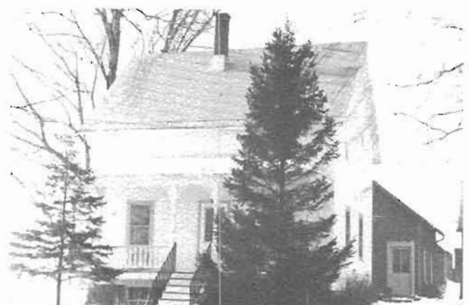
Maison située au 290, route 223
