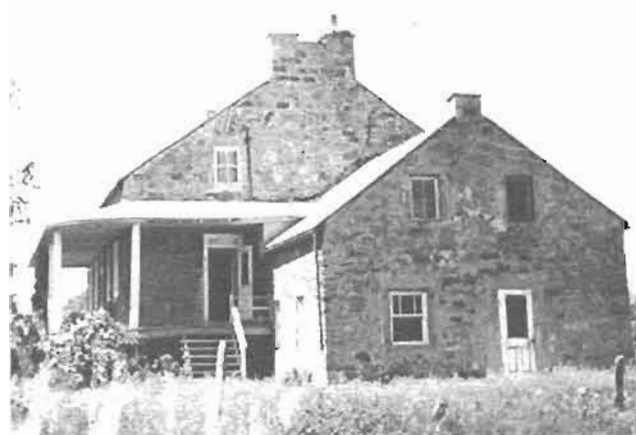
Résidence avant la restauration, en 1970. La galerie ceinturant la façade n'était pas d'origine puisqu'elle a été construite au début du siècle
