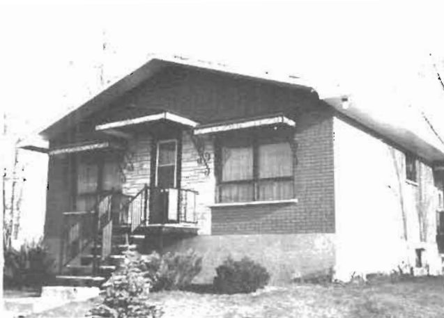
Résidence bâtie en 1966
