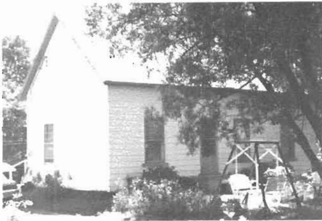
Maison du chef de gare transportée sur la Route 223, au 411 (Photo Héléne Gagnon)
