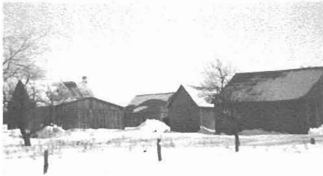
Bâtiments de ferme disposés de manière à réduire les poudrennes d'hiver (Photo: Hélène Gagnon)
