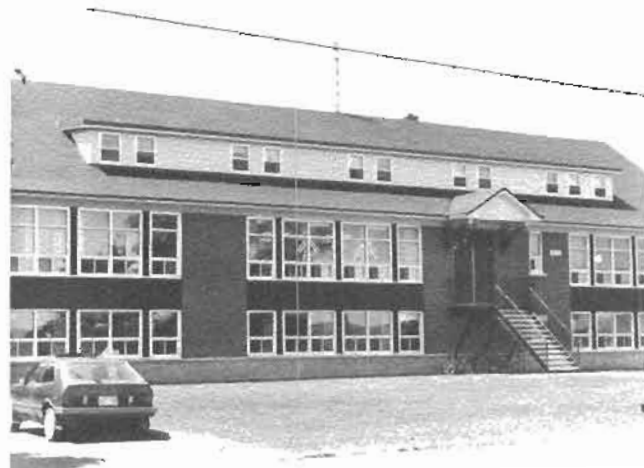
La construction de l'école centrale mettra fin aux petites écoles de rang plus que centenaires (Photo: Hélène Gagnon)
