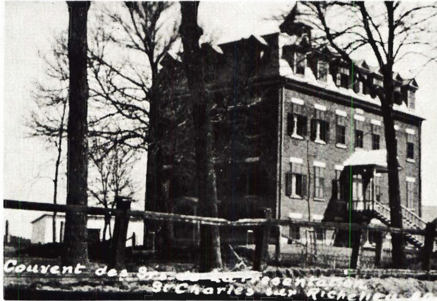
Couvent bâti en 1907; démoli pour faire place à l'école actuelle.
