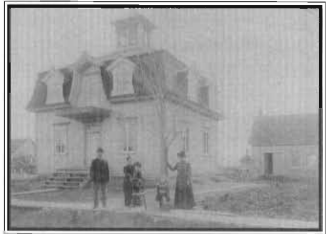
Maison A. Gauthier / rue Principale
