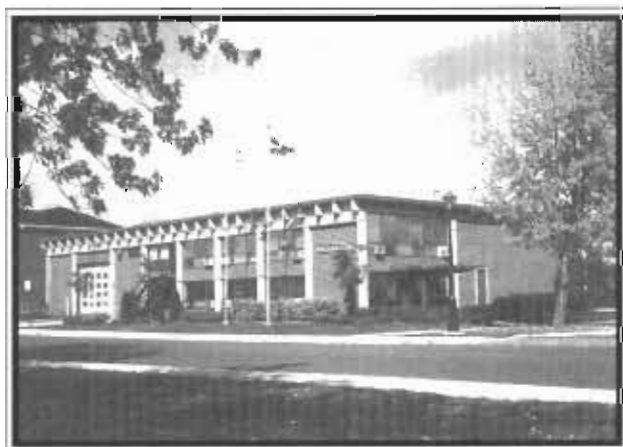
Police et Prévention des incendies
