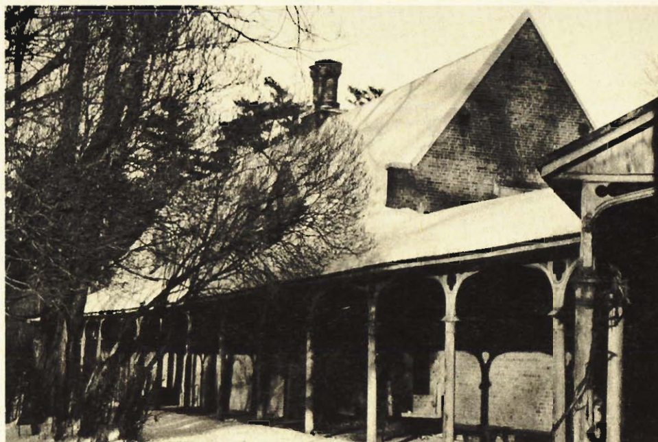
Le préau derrière les écuries. (Photo Gilles Vilandré).
