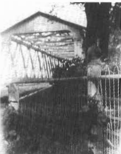
Pont sur la rivière L'Acadie, chemin Chambly vers 1930
