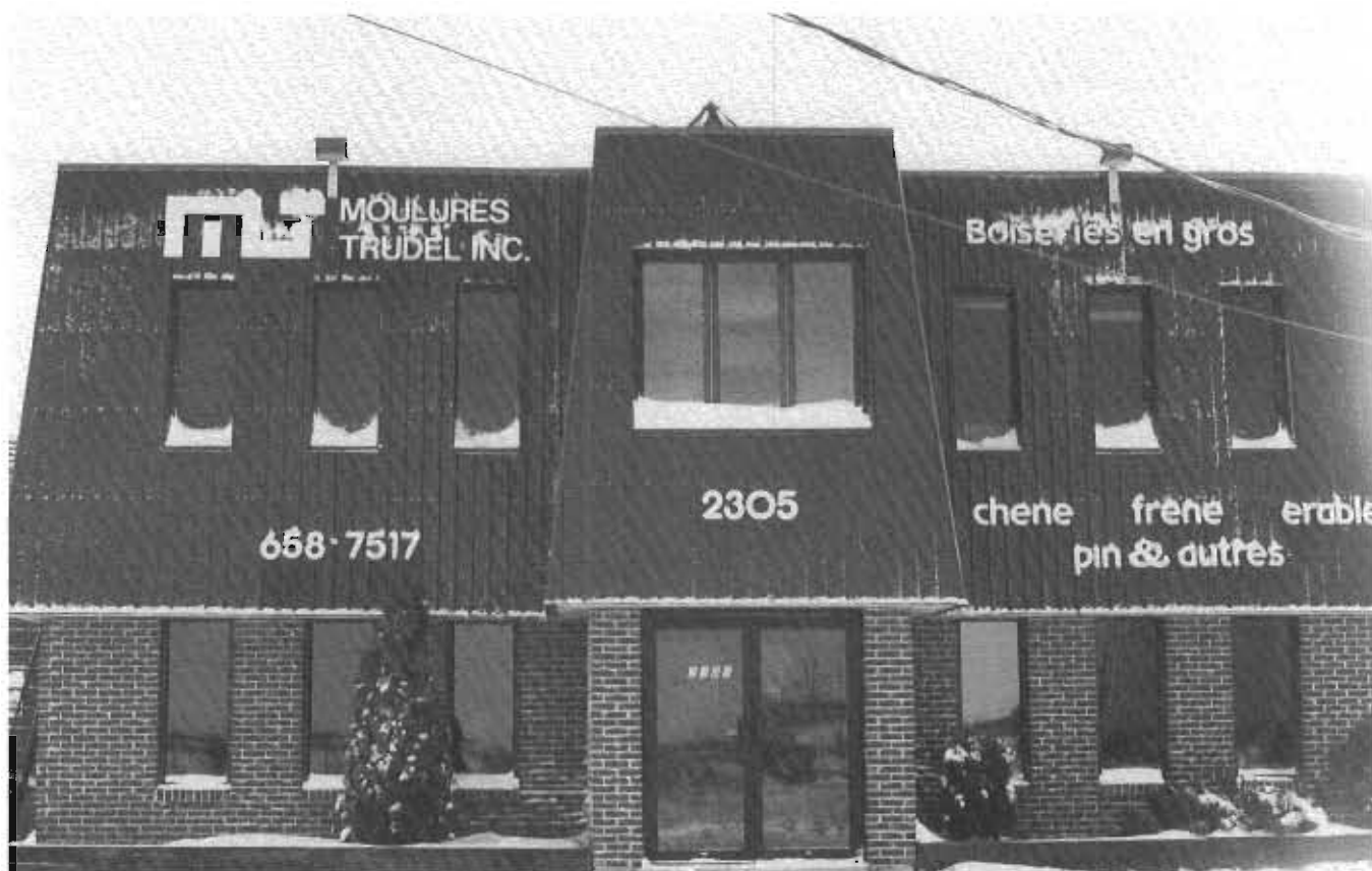
Moulores Trudel, édifice construit en 1971 - 2305 boulevard Brunelle
