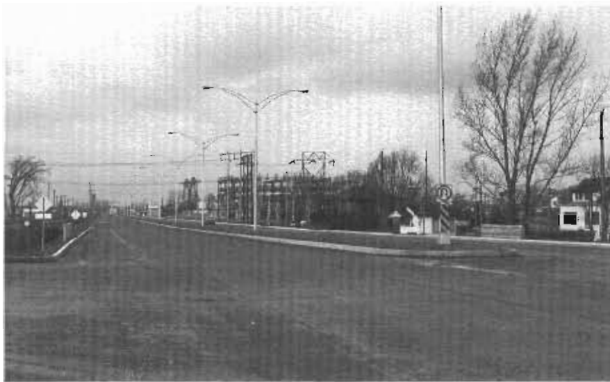
Prolongement Route 112 - Boulevard Périgny - 1974 (S.H.S.C. FRF)
