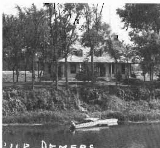
Maison paternelle de la famille Demers, construite en 1863 et détruite par les flammes en 1986
