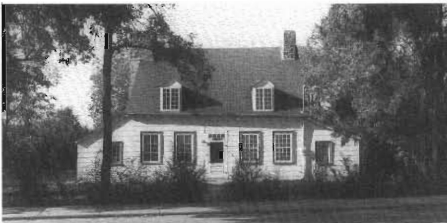
En 1980, avant la restauration (photo MAC 83)
