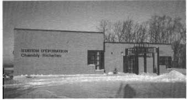
L'usine d'épuration des eaux usées de Chambly-Richelieu en opération depuis le printemps 1990
