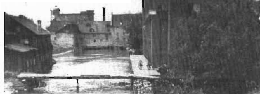
Usines Willett illustrant la façon dont la force hydraulique faisait fonctionner ses usines (S.H.S.C. FAA)
