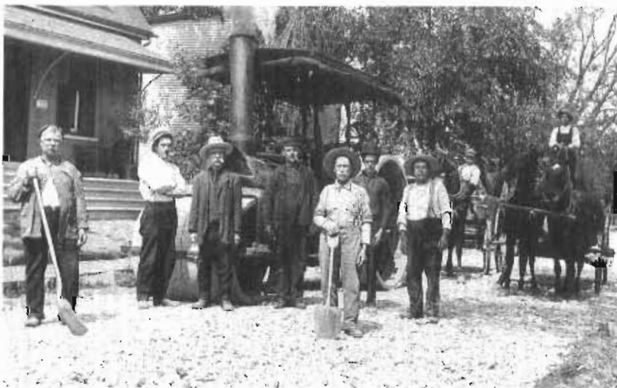
Chambly-Canton - pose du macadam (S.H.S.C.)
