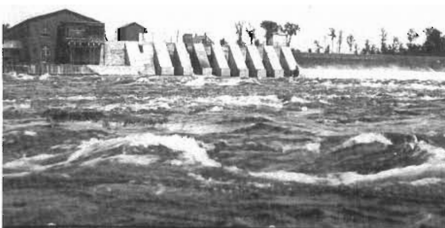
Vue de la centrale hydroélectrique, de l'évacuateur et d'une partie du deuxième barrage - 1910 (S.H.S.C. FAA)
