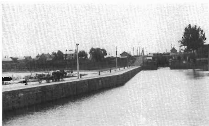
L'entrée du canal de Chambly (APC)
