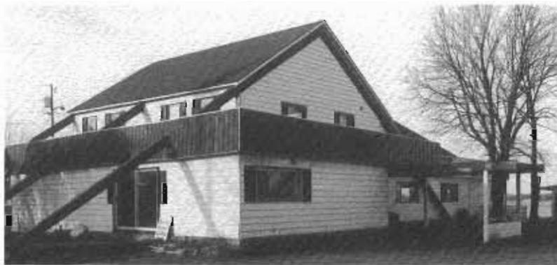
Photo de la Marina avant sa démolition.
