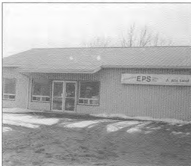
Bâtisse commerciale en mai 1995
