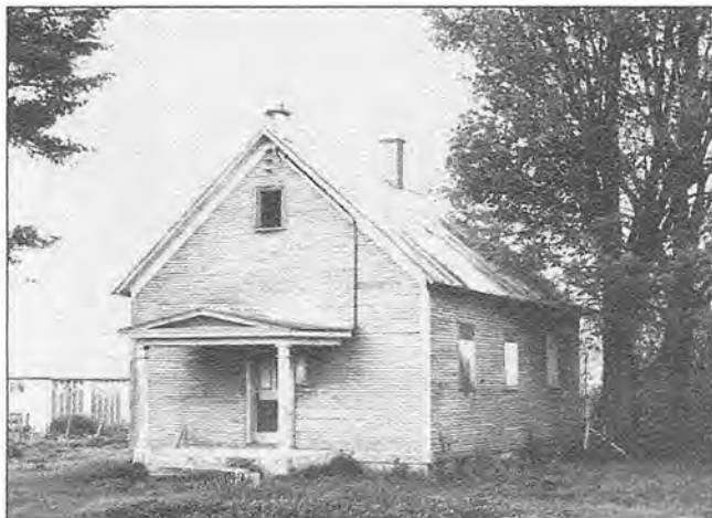
La chapelle anglicane avant les réparations
