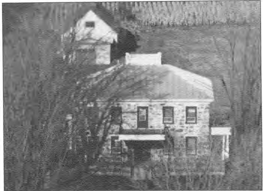
Presbytère construit en 1876
