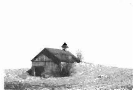
Caveau (bâtit en 1940) pour conserver les légumes
