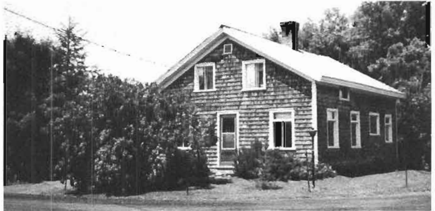
Bureau de poste de James Briggs, 1871-1897
