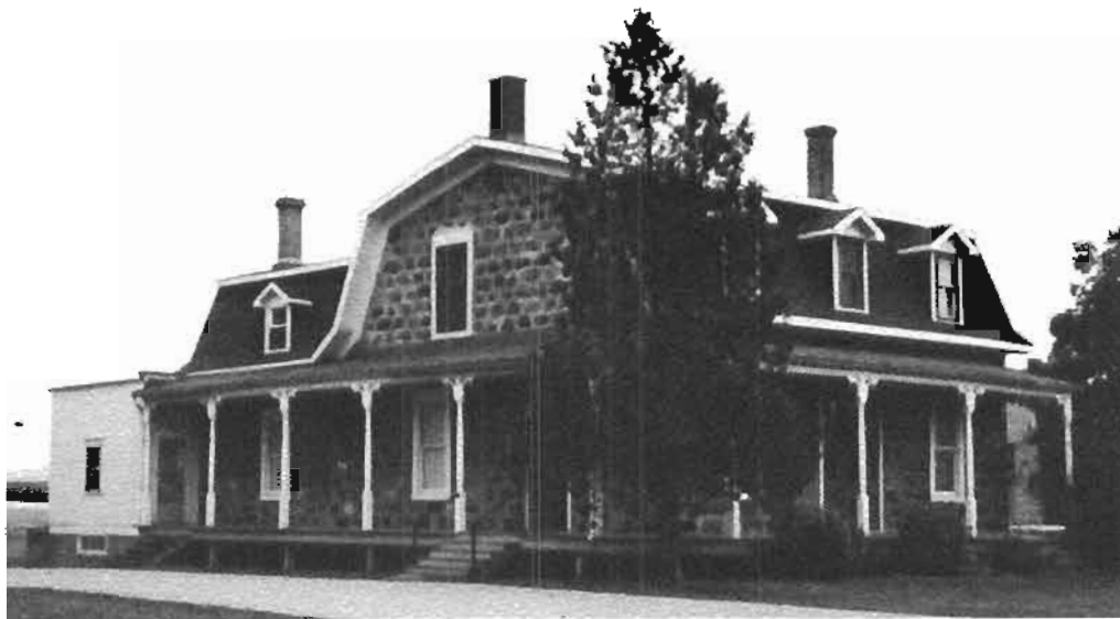
Presbytère construit en 1883
