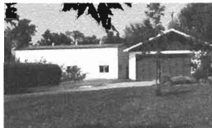
L'entrepôt et le garage
