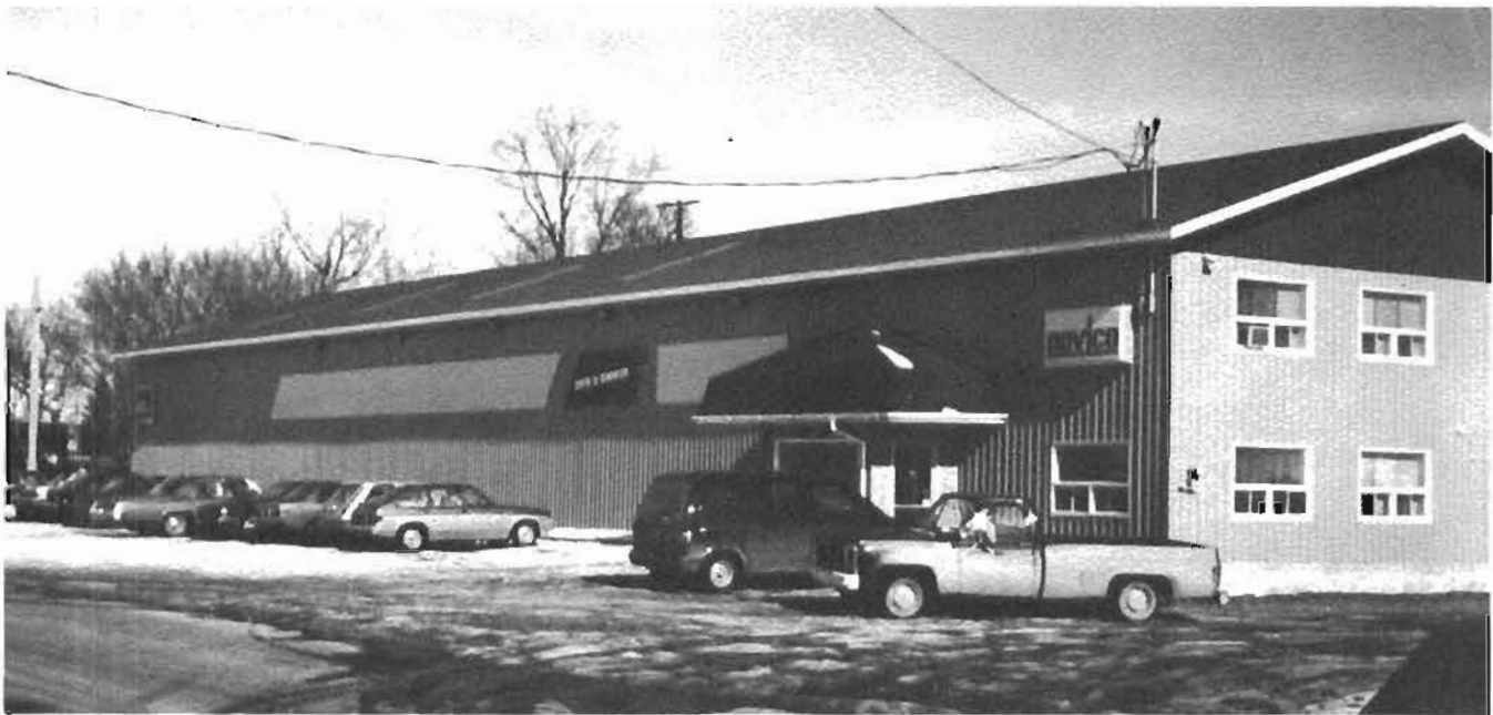
Centre de Rénovation et bureaux
