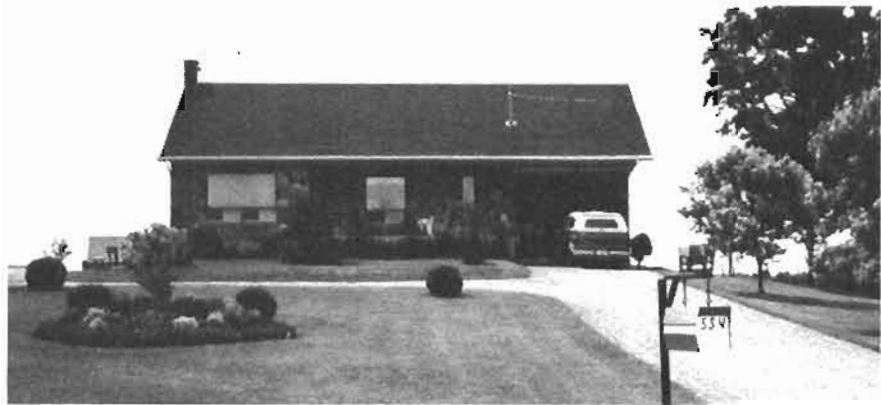
Notre maison, construite en 1977
