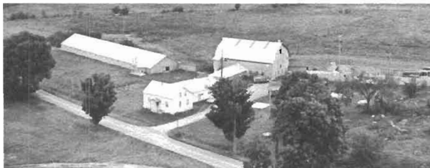
Ferme lors de l'achat en 1972, la porcherie a été reconstruite en 1974, et la grange-étable, détruite par un incendie le 10 décembre 1979
