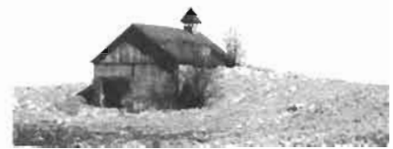
Caveau (bâtit en 1940) pour conserver les légumes
