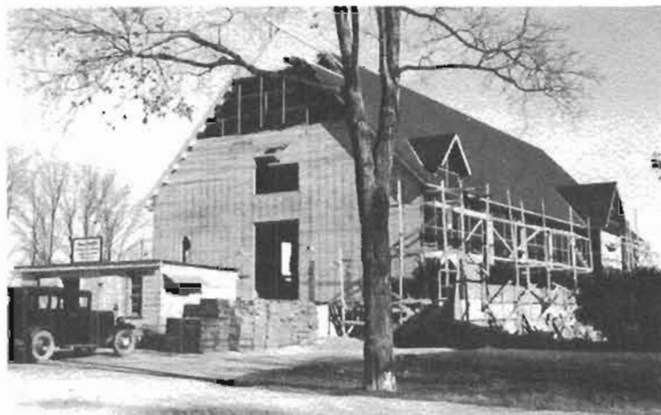
Construction de l'église, automne 1949
