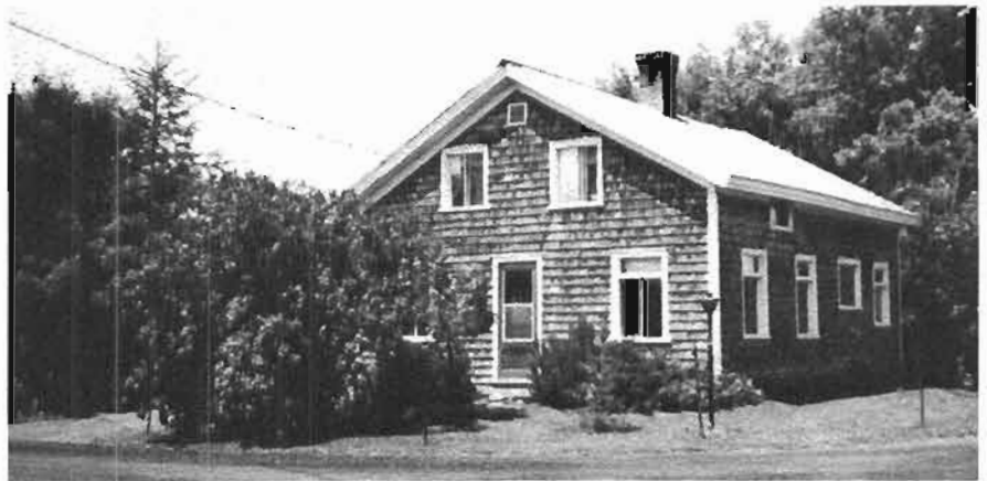
Bureau de poste de James Briggs, 1871-1897
