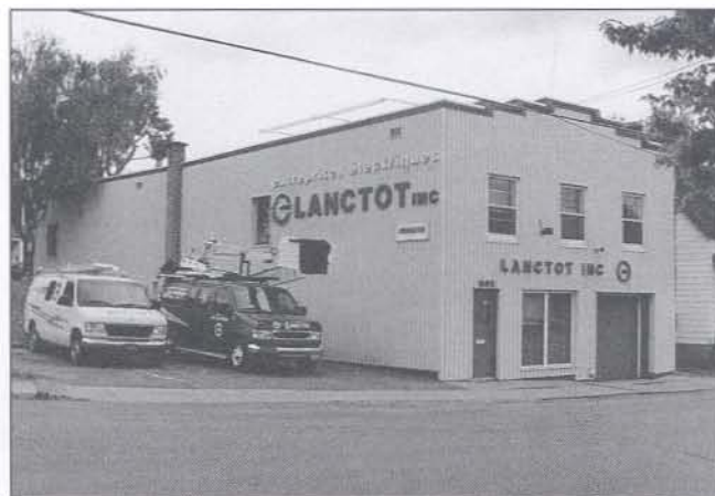
Adresse actuelle: 632, rue Principale Est
