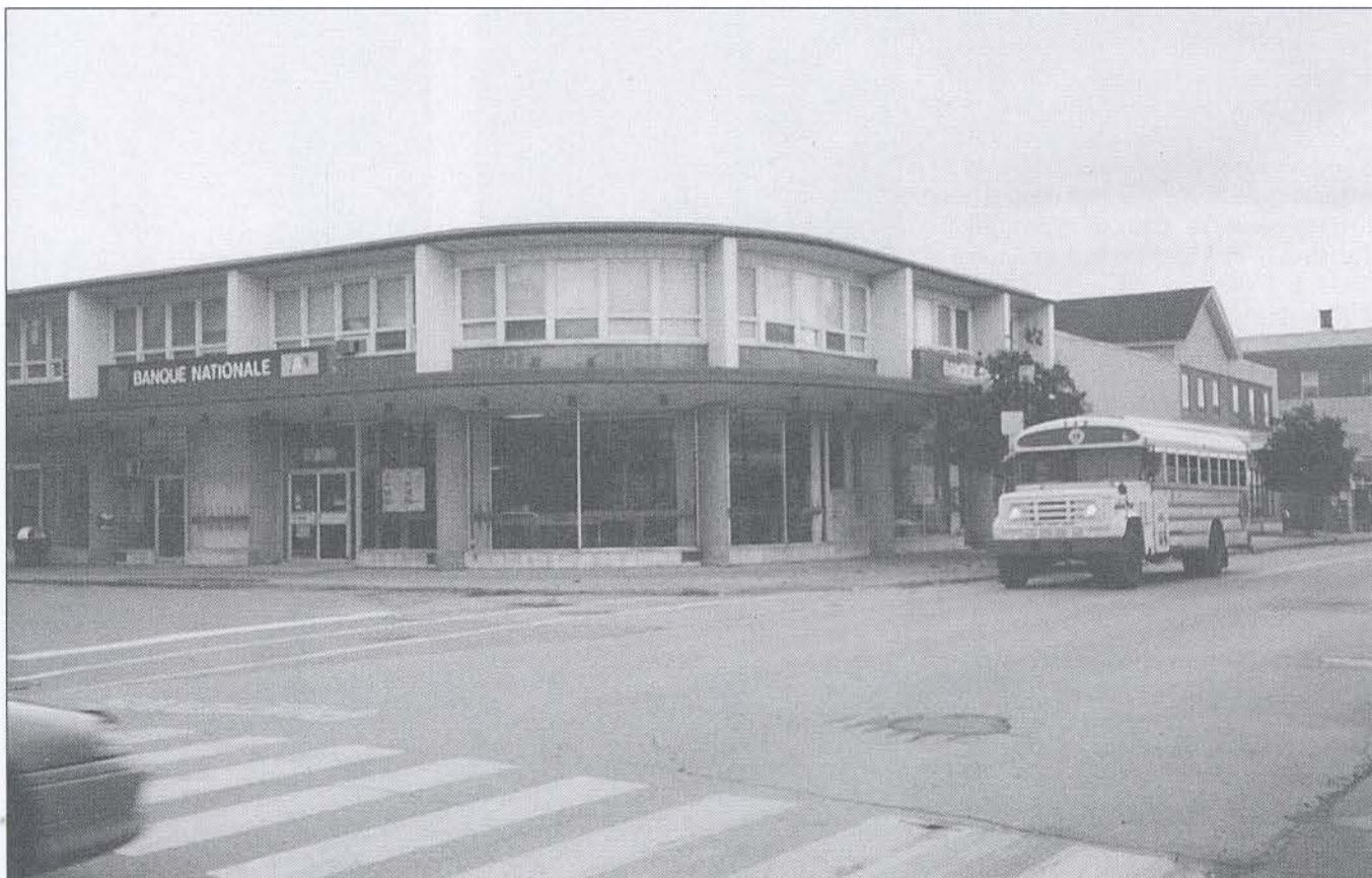
La Banque Nationale du Canada au 280, rue Principale Est
