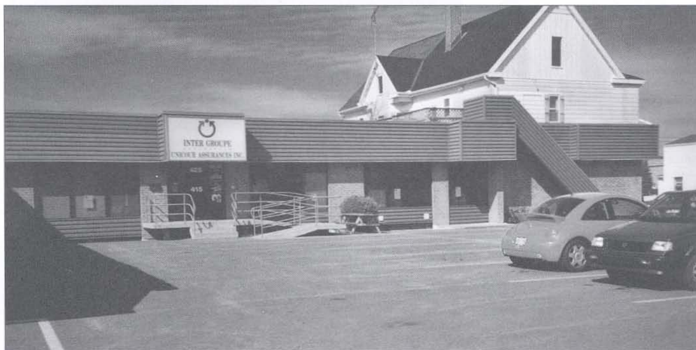
Vue arrière du bâtiment de Unicour incluant ancienne Bâtisse de A.B. Inc.
