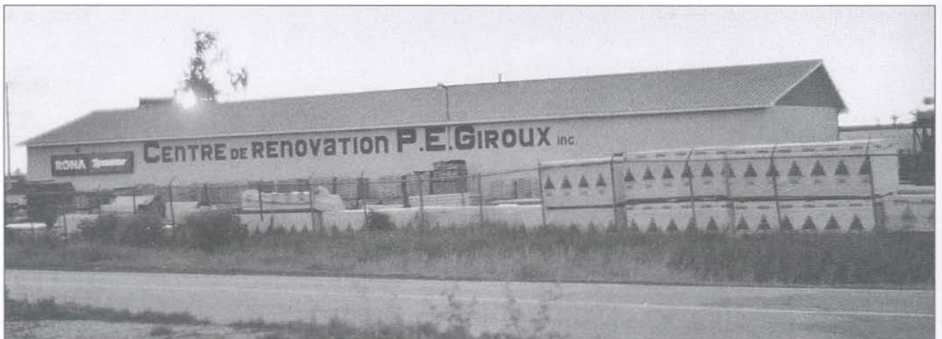
Centre de rénovation P.E. Giroux vu de la route 104
