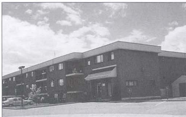
PLACE DE L'AMITIÉ - 1 re construction
