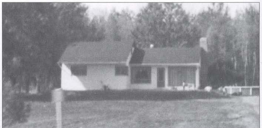
Construction de la maison à la campagne.
