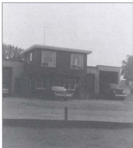
Bureaux et garage Laguë Express
