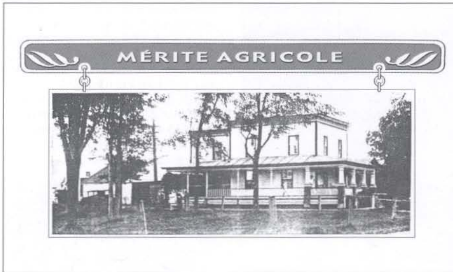
Maison construite début 1900 (photo prise en 1929)
