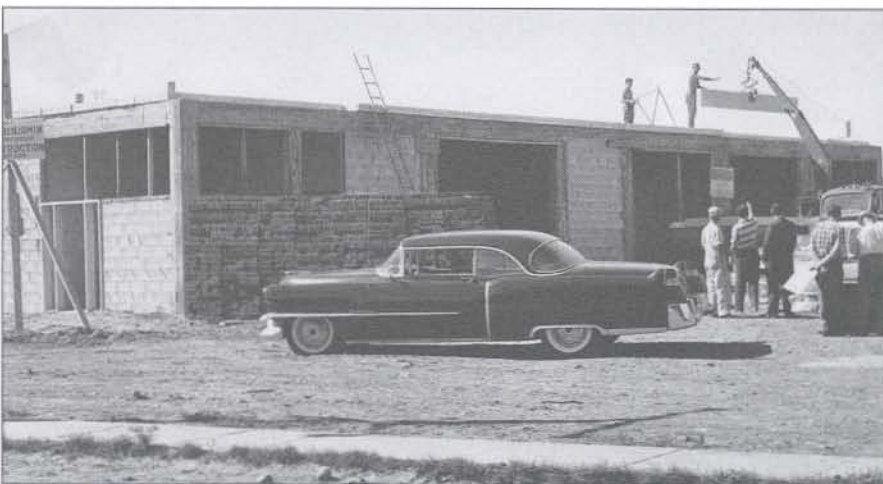
Garage municipal construit au milieu des années 1960, entrepreneur Gérard Benjamin CAB
