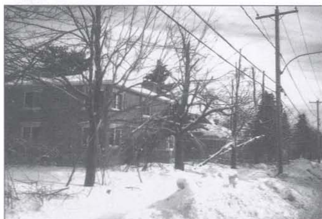
La maison familiale des Dubois construite en 1954, au 257 de la rue Saint-Grégoire (après le verglas du début janvier 1998)
