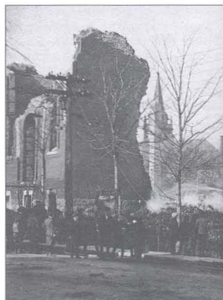
Incendie du premier hospice Sainte-Élizabeth.
