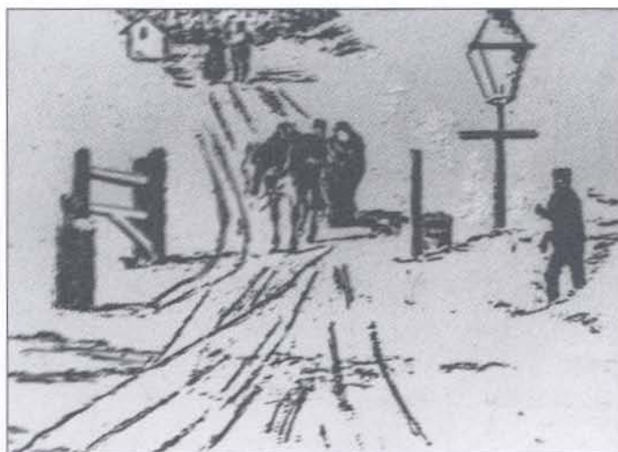
Poste de péage entre Sainte-Brigide et Farnham
