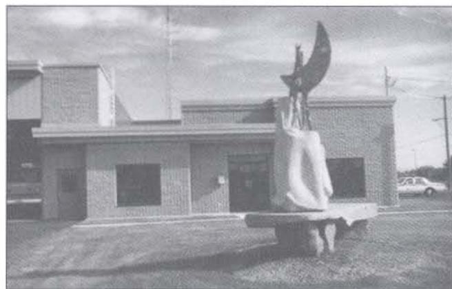
Nouvelle caserne des policiers et pompiers
