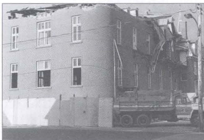
Démolition du couvent de Farnham en novembre 1983
