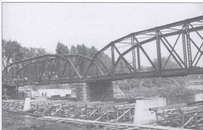
Démolition du pont Honoré Mercier en 1949 Courtoisie Simone Laroche
