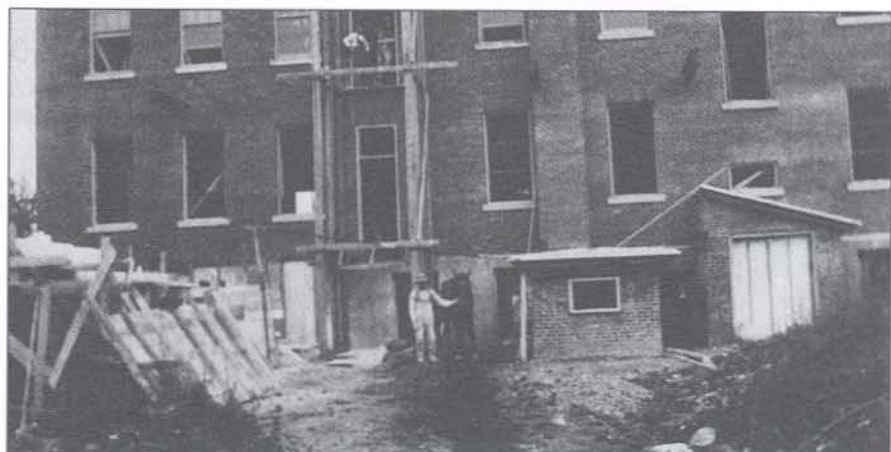
Construction d'un deuxième hospice à Farnham. Pour monter les briques aux étages supérieurs, l'ascenseur consistait en une plate-forme, poulie et câble tiré par un cheval CAB
