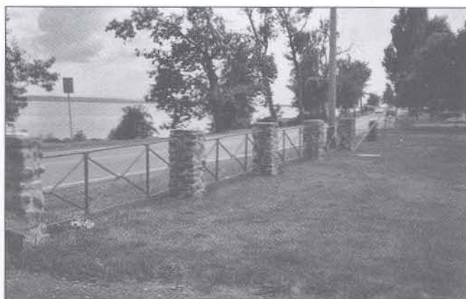
Les anciens garde-fous du deuxième pont installés à Venise-en-Québec
