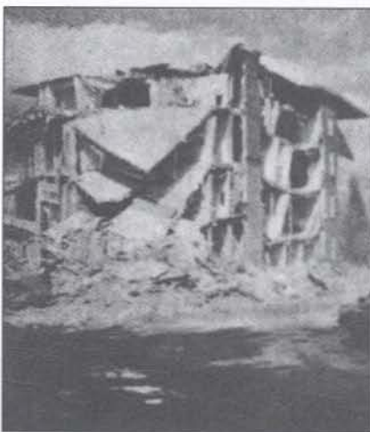
Dynamitage du deuxième hospice Sainte-Élisabeth lors de sa démolition en 1976 CAB
