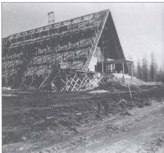
Église Saint-Fabien, construction
