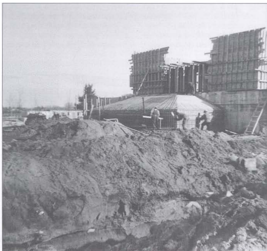
Église Saint-Fabien, construction
