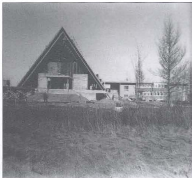
Église Saint-Fabien, construction
