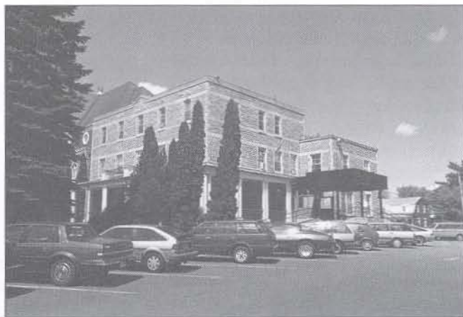
Presbytère construit en 1930
