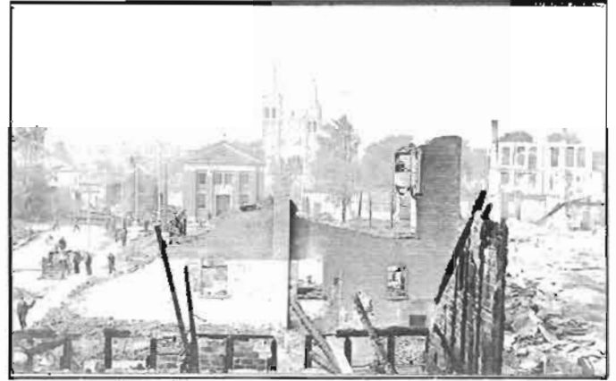
Rue Principale: vue du pont
