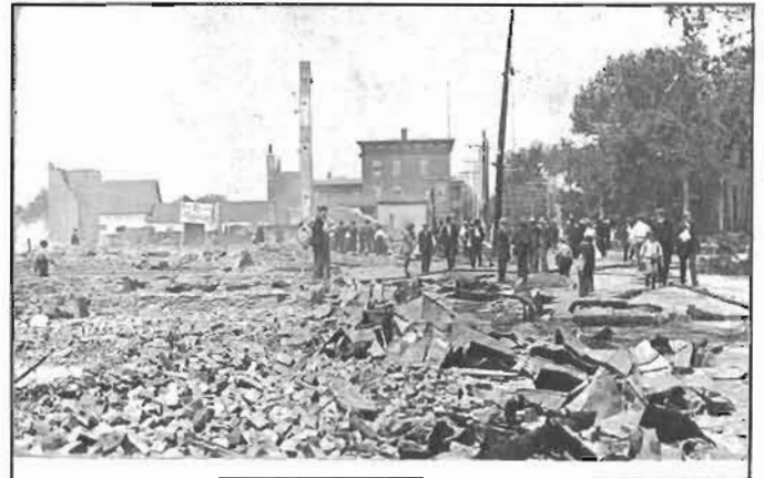
Vue après le feu, quadrilatère Hôtel de Ville, Principale et St-Vincent
