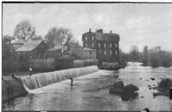
Vue du moulin à farine de M. Berthiaume et de la digue
