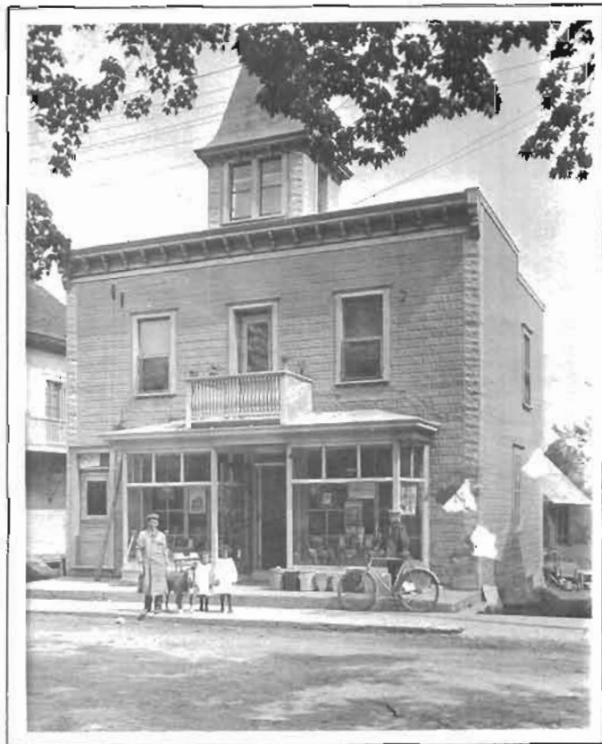
Site actuel de Nettoyeur Farnham, rue Principale, prop. M. Jean Vallée
