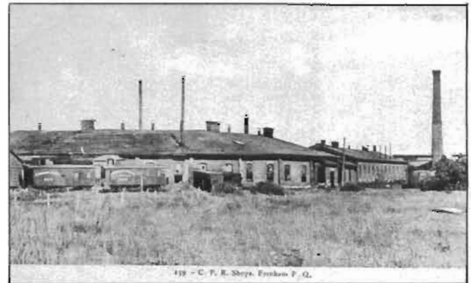
Atelier de réparation du C.P.R.
