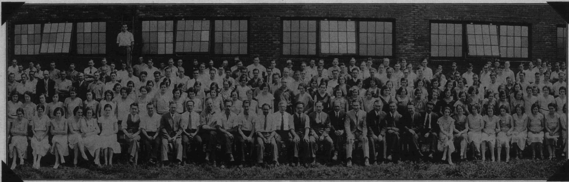
Une photo du personnel de la Bruck Mills en août 1932. La muraille a été démolie peu de temps après pour faire place au nouveau département de tissage.
