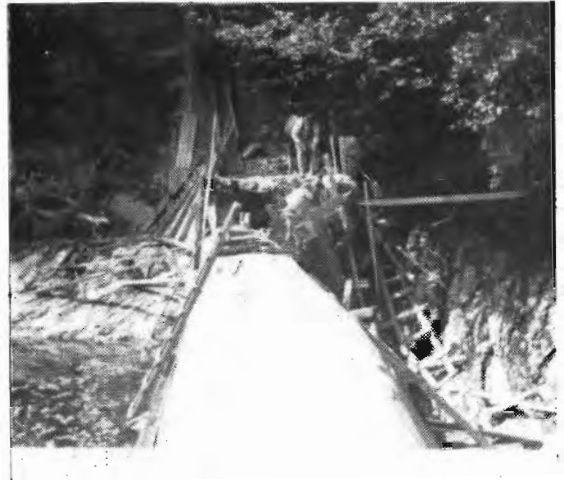
Photo prise durant la construction du barrage de ciment qui remplaça le barrage de bois.
