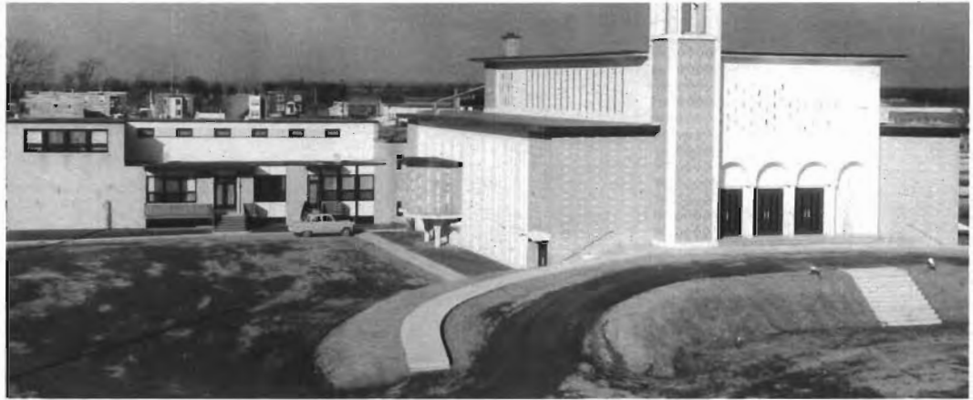
Le talus de la façade de l'église.
