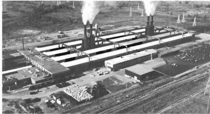
Vue aérienne de l'usine de la Société d'électrolyse et de chimie Alcan Ltée. (Usine Beauharnois à Melocheville)
