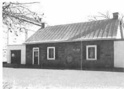
La vieille salle de la Fabrique St-Clément.
