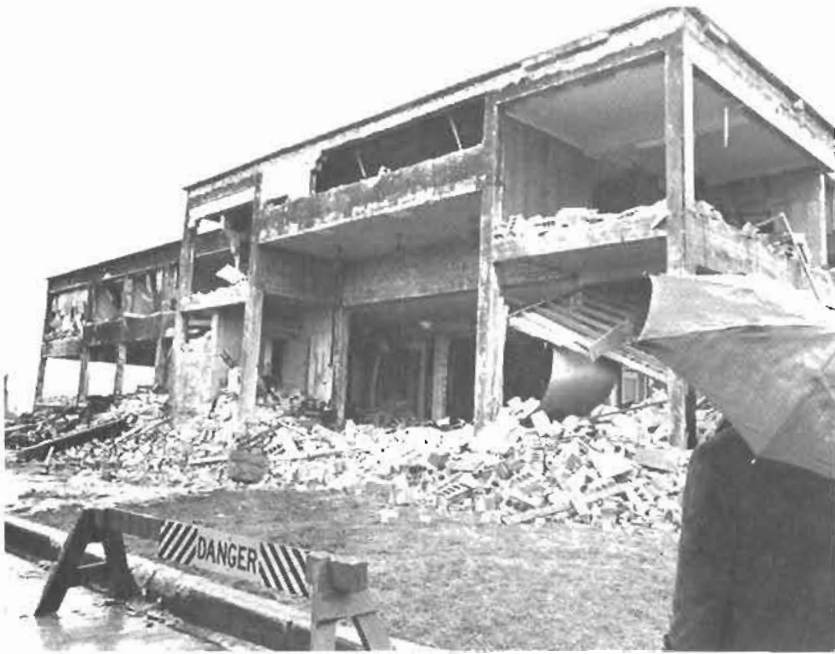
Démolition du Centre des Loisirs de Beauharnois en 1981.
