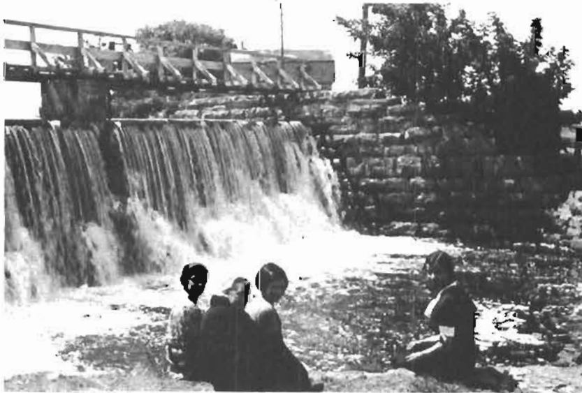
Photo d'un déversoir qu'on avait dû ajouter à chacune des neuf écluses.
