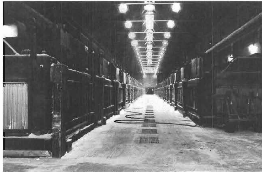
Vue d'une salle de cuves de l'usine Beauharnois de la Société d'électrolyse et de chimie Alcan Ltée à Melocheville.
