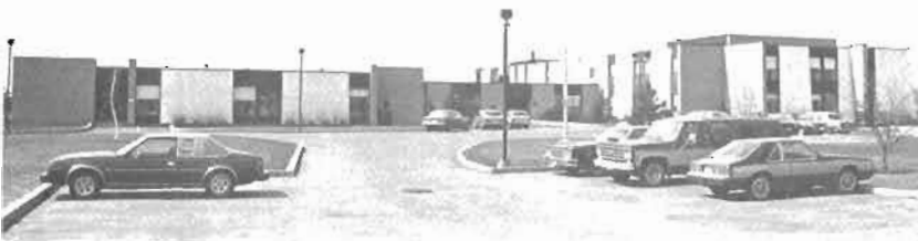
Centre d'accueil de Beauharnois (1985).
