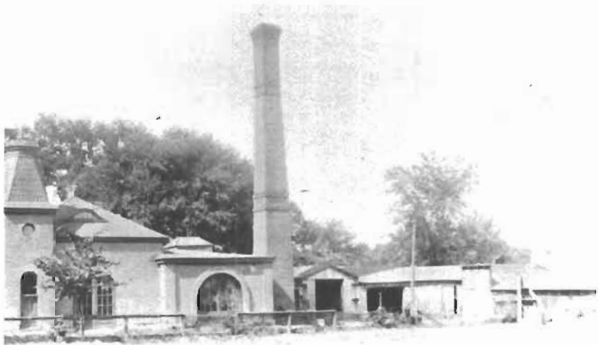
Ancien aqueduc de Beauharnois sur la rue St-Laurent.
