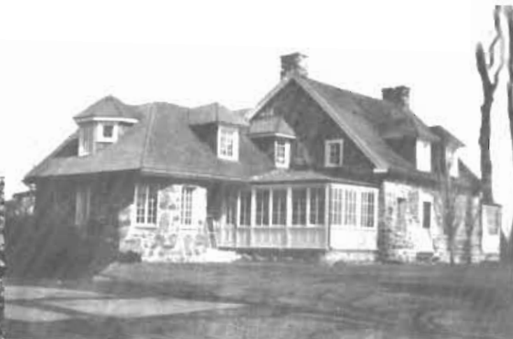
Maison de Georges Simard, démolie lors de la construction de l'autoroute, coll. Société d'histoire Mouillepiéd.
