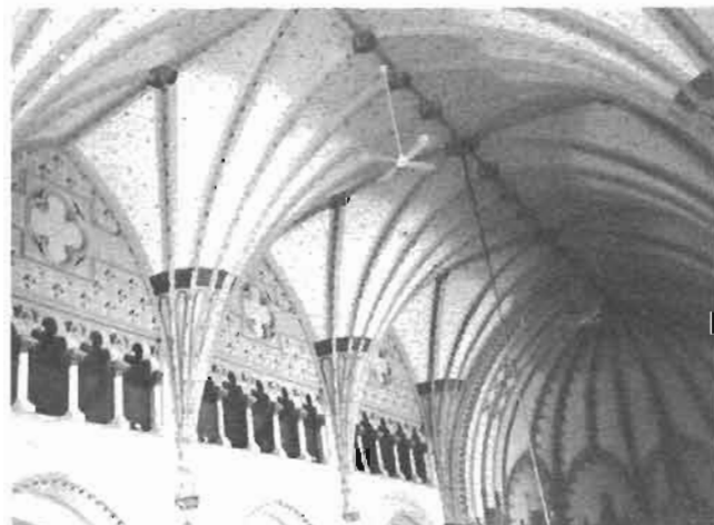
Intérieur de l'église (la voûte)
