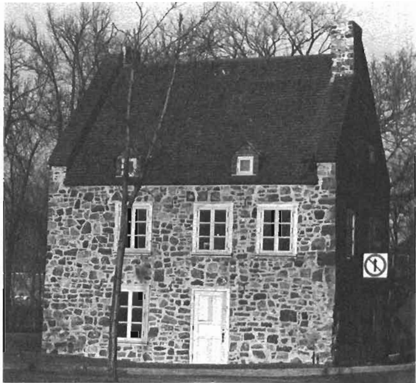
Maison Rollin-Brais. Construite entre 1794 et 1801, la Maison Rollin-Brais (205 chemin de Chambly) abrita successivement une forge et une auberge. Achetée et restaurée par la Ville de Longueuil, elle loge aujourd'hui la Chambre de Commerce de la Rive-Sud
