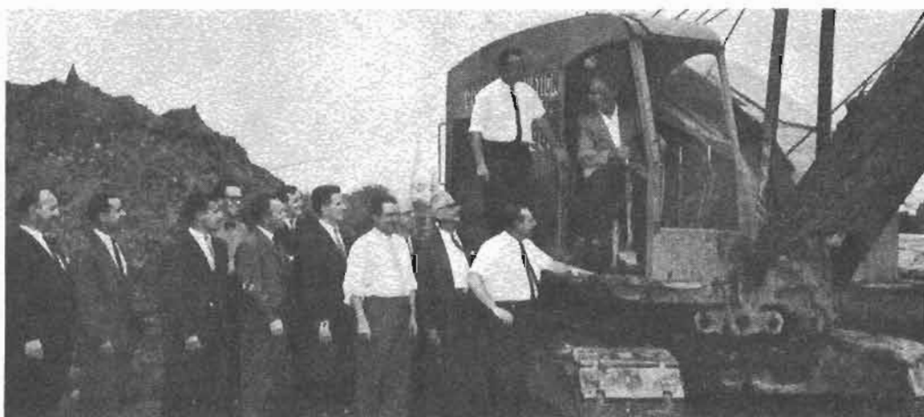
Première pelletée, construction du Centre d'Achats Saint-Hubert (1965)
