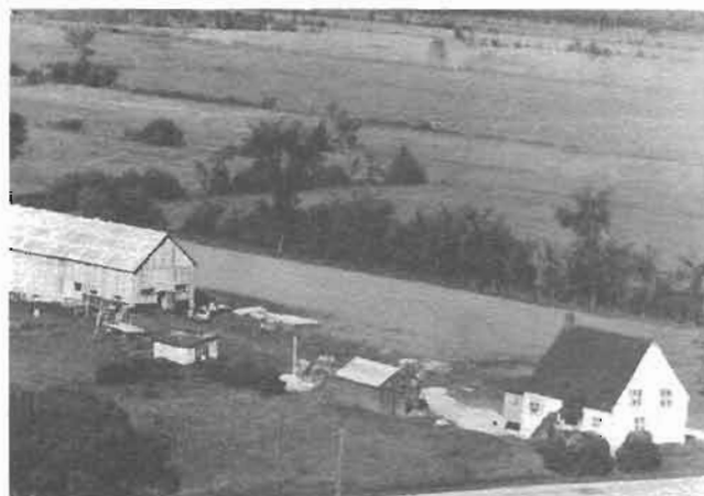
Leur terre sur le Chemin Chambly à Saint-Hubert
