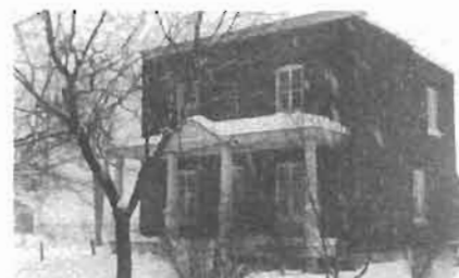
Maison 3717 Chemin Chambly, Longueuil déménagée à Saint-Hubert
