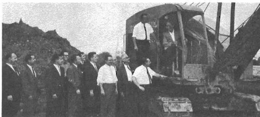
Première pelletée, construction du Centre d'Achats Saint-Hubert (1965)
